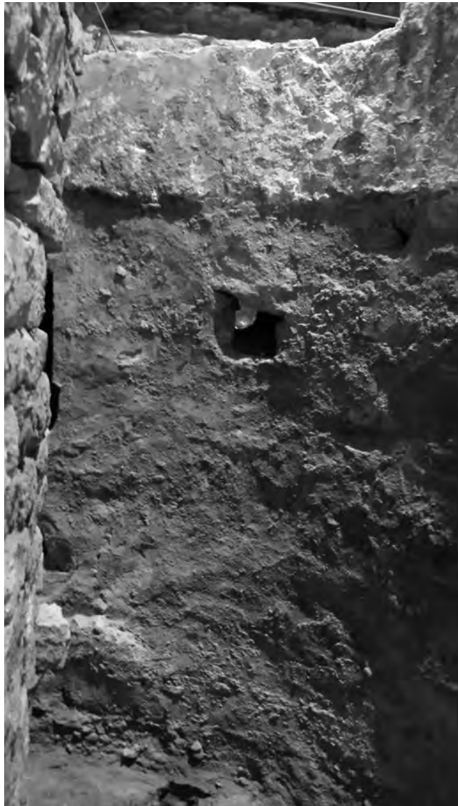
Figura 2 Vista de l'absis des de l'interior de la cripta. [Fotografia: Pere Vivas]
