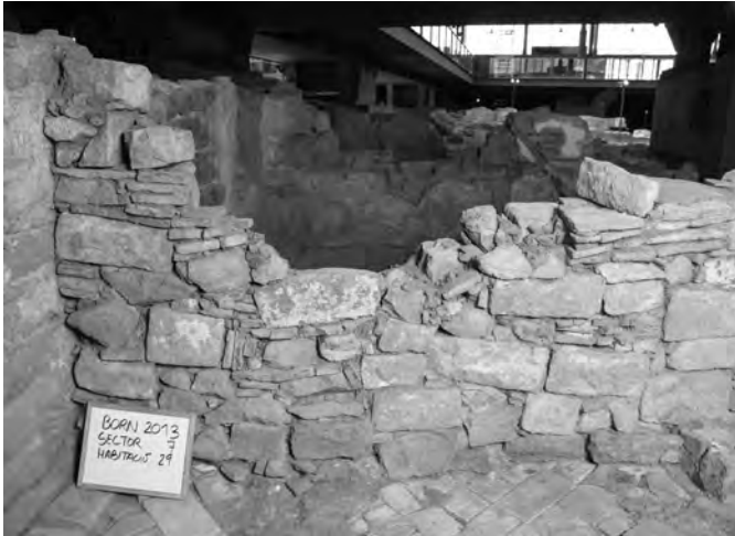
Figura 15 Detall d'un mur refet després del setge. [Fotografia: El BornCC©Flare Estudi 2013]
