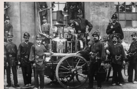
Merryweather Valiant II 1896. Adquisició de 1896. Fabricació anglesa. Bomba d'incendis de vapor lleugera amb un cabal de 900 l/m. Calien un mínim de dos bombers per desplaçar-la. ABB
