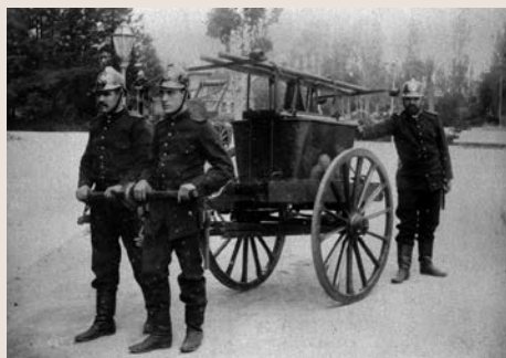
Bomba MTM 1875. Adquisició de 1875. Bomba manual d'incendis fabricada per la Maquinista Terrestre i Marítima a partir d'un model francès. Per aspirar aigua directament d'una bassa o canal. Té un dipòsit que es pot omplir amb galledes d'aigua. ABB
