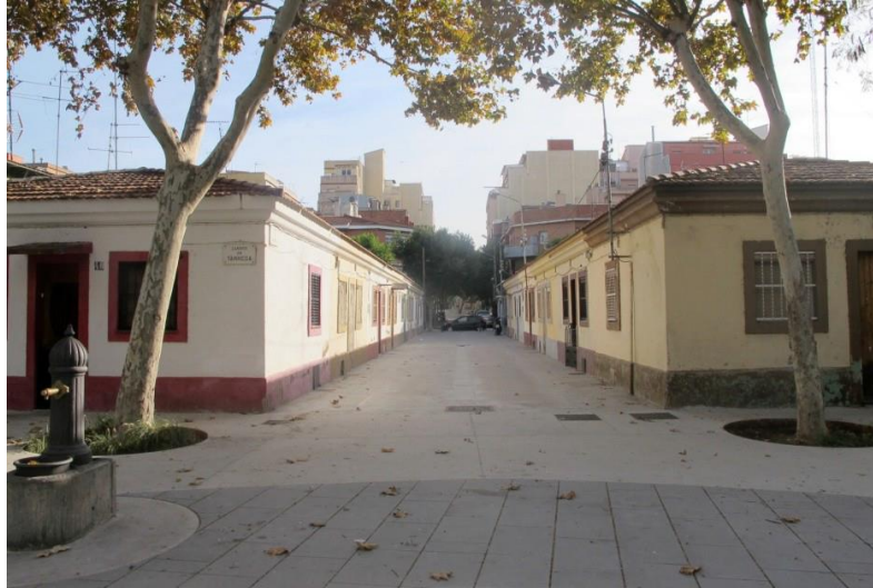
Vista dels habitatges del Bon Pastor
