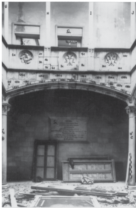
Primer pis i planta baixa del pati de la casa Gralla amb les pedres numerades per al seu desmuntatge
