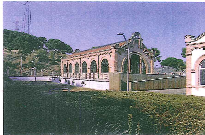
Vista de conjunt de l'exterior del dipòsit municipal de primera elevació. Aquest recinte és conegut també com a Casa d'les Aigües de Trinitat Nova. A la imatge es pot observar l'exterior de la sala d'aforament, una part de la zona superior del dipòsit de primera elevació amb la tanca exterior de fons i, a la dreta, la caseta del guarda, situada en el mateix eix de la sala d'aforament, МУНБА.
