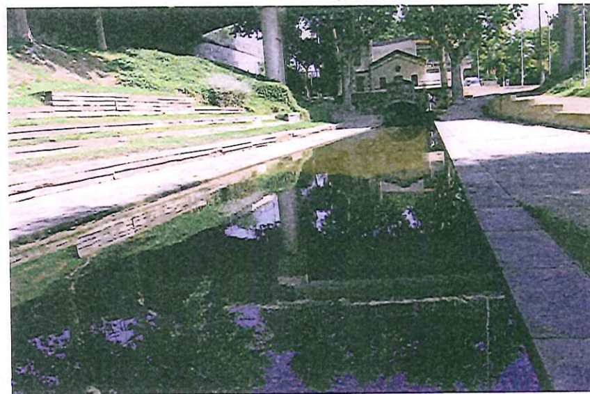
Boca mina de Montcada, també coneguda com el Reixegó. En primer pla, el tram inicial descobert del Rec Comtal. La boca mina, protegida per una reixa, contenia el sistema de distribució de l'aigua captada per les galeries de Montcada entre l'Ajuntament de Barcelona i els usuaris de la sèquia Comtal. Es pot veure també la casa del Guarda, enretirada a un nivell superior, муња.
