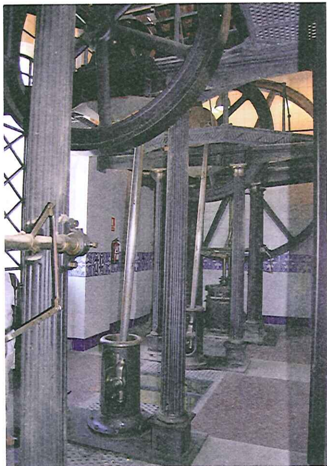
Sala de màquines d'extracció dels pous de Montcada. Constava de dues màquines de vapor Alexander tipus Wof amb 100 CV de potència. Accionaven quatre bombes de vapor amb capacitat per extreure 23.000 m 3 diaris. El pou central disposava de dues bombes, i els laterals, d'una cada un, MUHBA.
