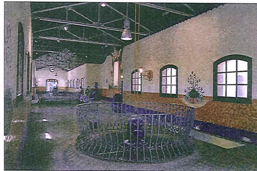
Interior de la sala dels tres pous de Montcada. En primer terme el pou lateral mitjà, al fons el central més gran i, en darrer terme, el lateral petit. La decoració és d'inspiració modernista als murs i s'observa l'estructura de ferro al sostre. Destaca una inscripció commemorativa de l'acord de construcció de l'Ajuntament de Barcelona del 1878 al costat dret i dues antigues electrobombes exposades a banda i banda, MUHBA.
