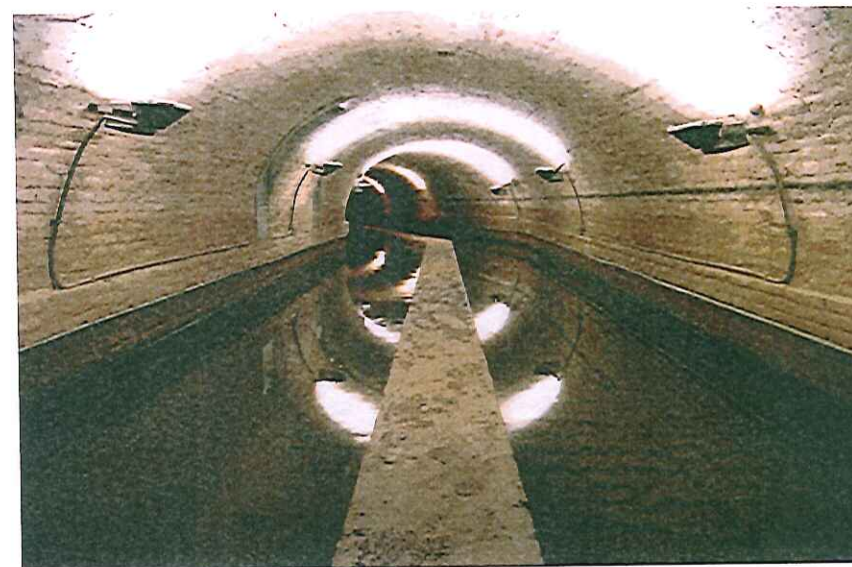
Galeria central de la mina de Montcada. Interior del primer tram de la galeria de les mines de Montcada, vista des del punt d'observació al soterrani de la casa del guarda. El conjunt el formen 2.350 m de galeries subterrànies de captació per filtració de l'aquífer del Besòs i de conducció fins al Reixegó, муња.
