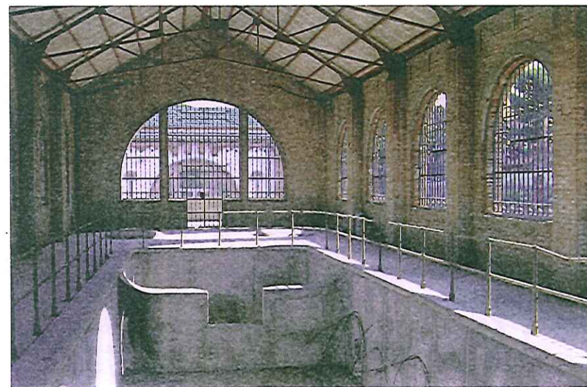
Interior de la sala d'aforament del dipòsit de Trinitat Nova. Sala del dipòsit d'aforament obert al qual arriba l'aigua des de la canonada d'impulsió de 50 cm procedent de l'estació elevadora abans d'entrar en els compartiments del dipòsit. Es troba sobre l'eix transversal del dipòsit i les seves característiques arquitectòniques són similars a les de la sala de màquines de l'estació elevadora, МУНБА.
