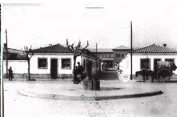
nº 11 C/Bellmunt. Any 1929 Casa fundacional El fet d'estar enderrocada, fa que sigui viable reconstruir i reproduir totalment l'aspecte original. Es recupera el pati amb el safareig i bany originals
