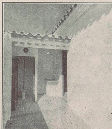
Patio, lavadero y W. C.
