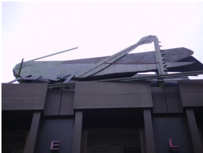
Llagosta situada a dalt de tot de la façana.
