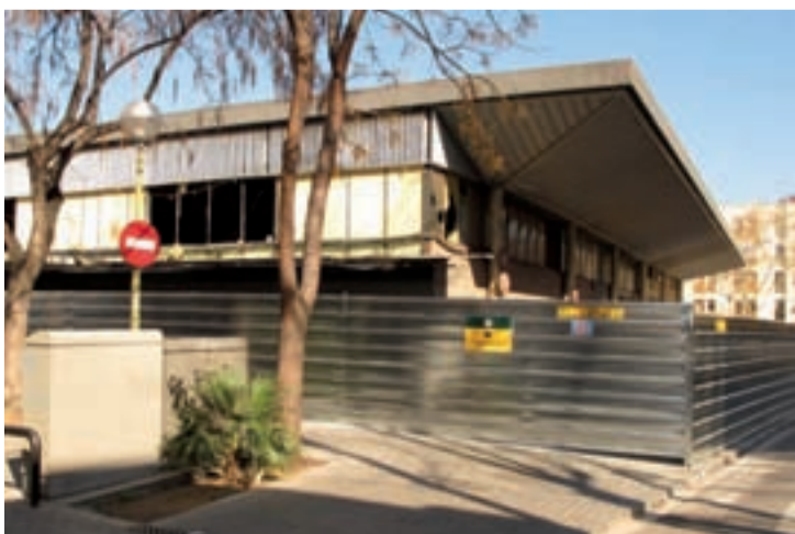
L'antic mercat, envoltat de tanques.
