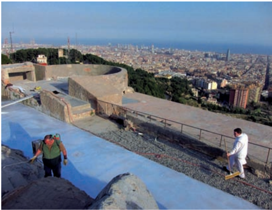
Uns operaris treballen en la recuperació de la bateria.
