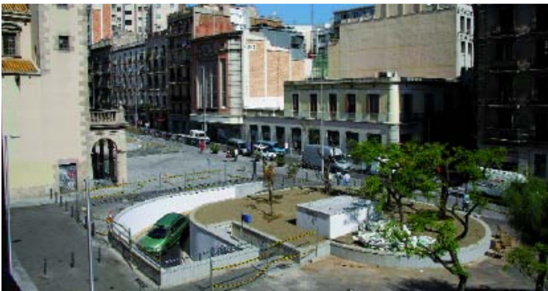
La plaça ha estat en obres durant deu mesos.
