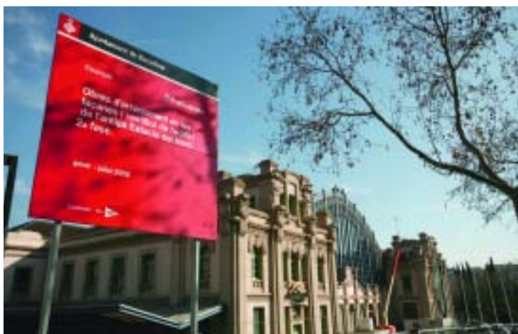
Façana rehabilitada de l'estació del Nord d'autobusos.
