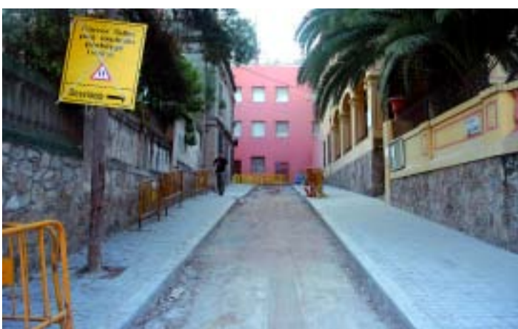
Imatge del carrer Sant Camil encara en obres.
