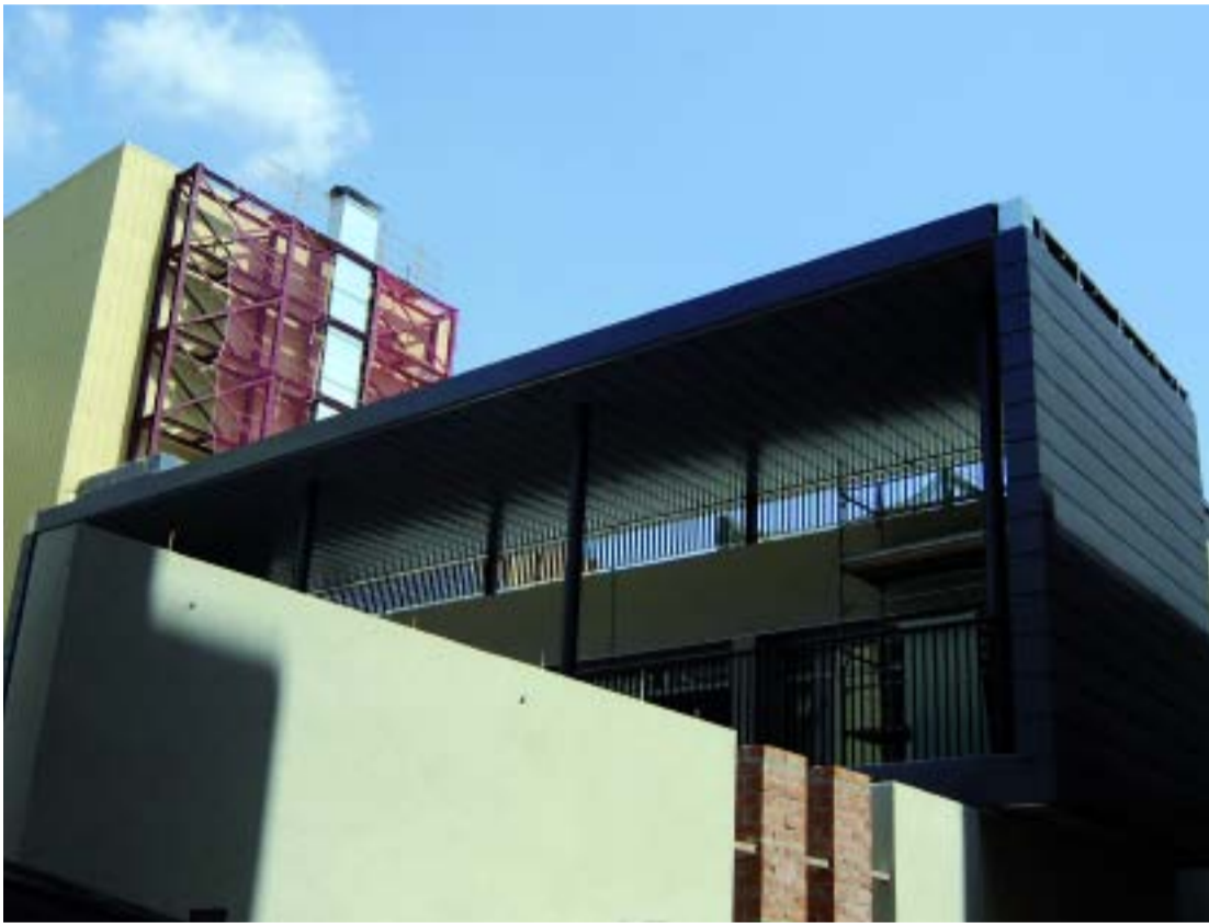
El nou edifici, encara en obres al final del mes de juliol.
