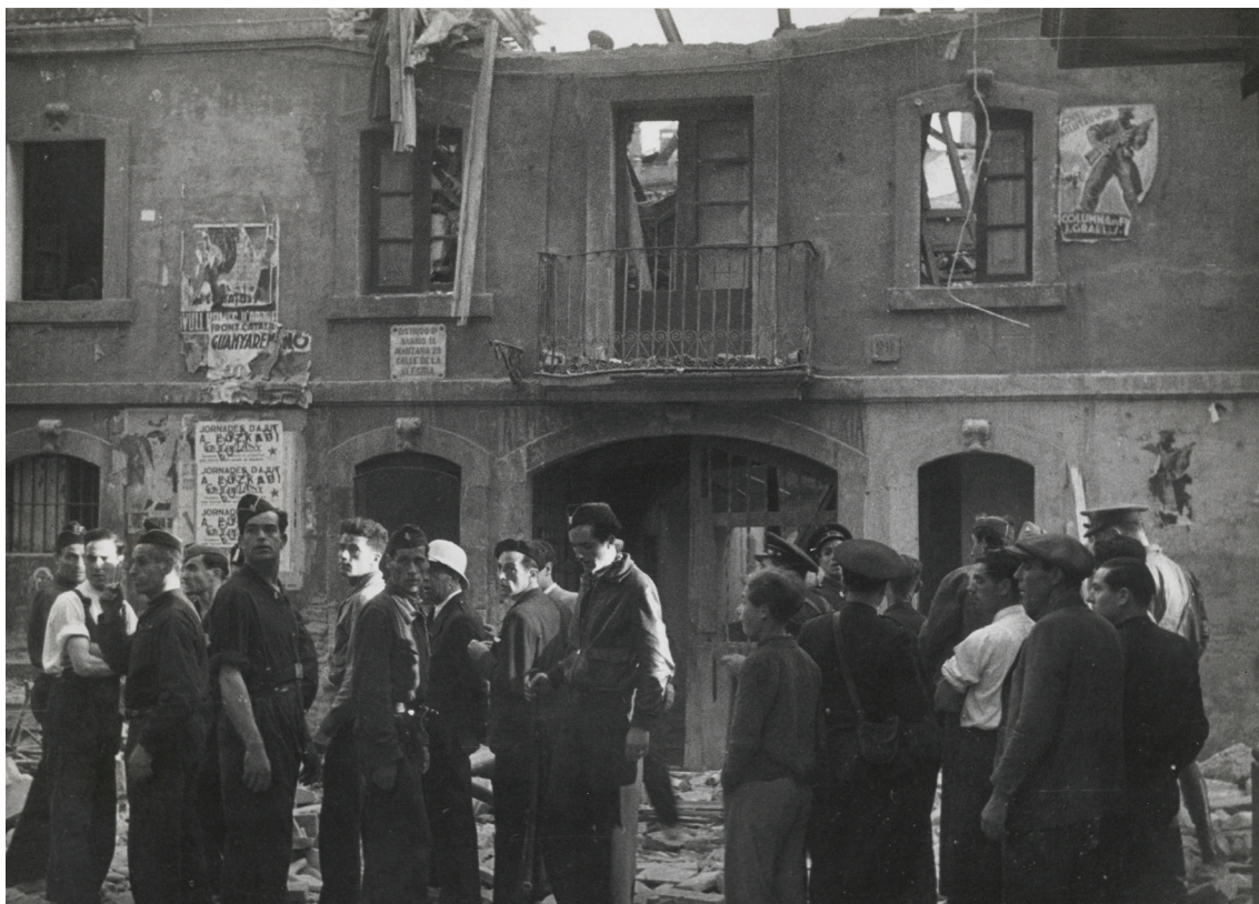
Figura 6 Bombardeig a Barcelona. Estat de com van quedar alguns dels edificis després del bombardeig. [Autor: Carlos Pérez de Rozas. Data: 29/05/1937. Arxiu Fotogràfic Barcelona, AFB]
