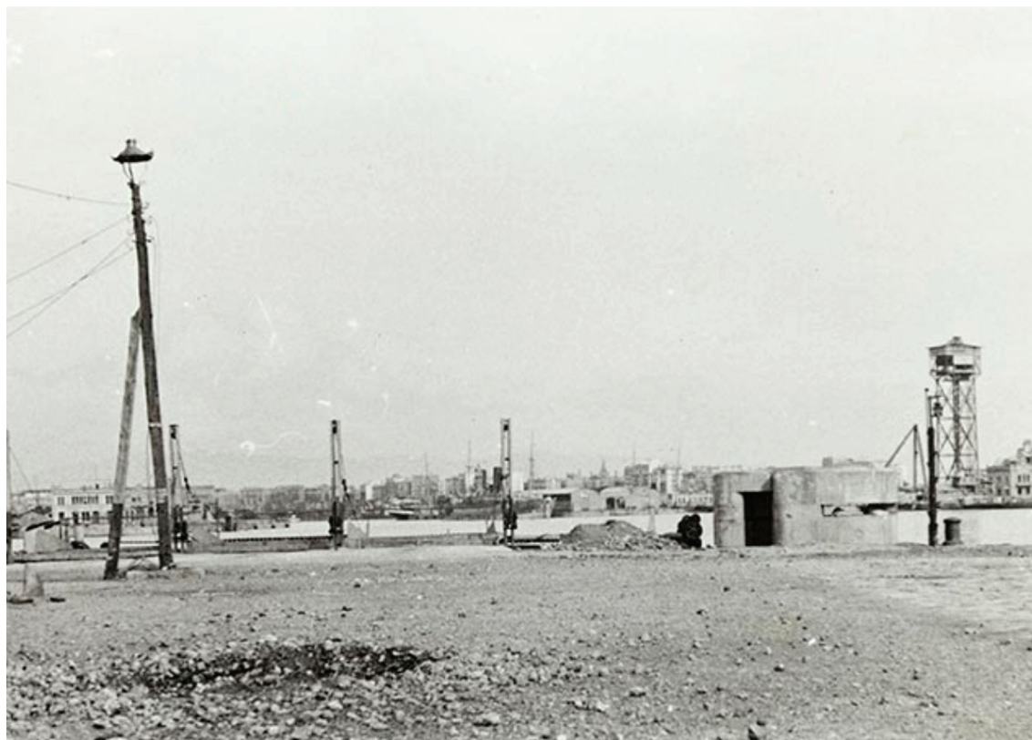
Figura 18 Moll de Sant Bertran de Barcelona amb la torre de Sant Sebastià al fons. S'observa un niu de metralladora de ciment i l'impacte de l'explosió d'un bombardeig per part de l'Aviació Legionària italiana. [Arxiu Nacional de Catalunya, ANC1-1250-N-6]
