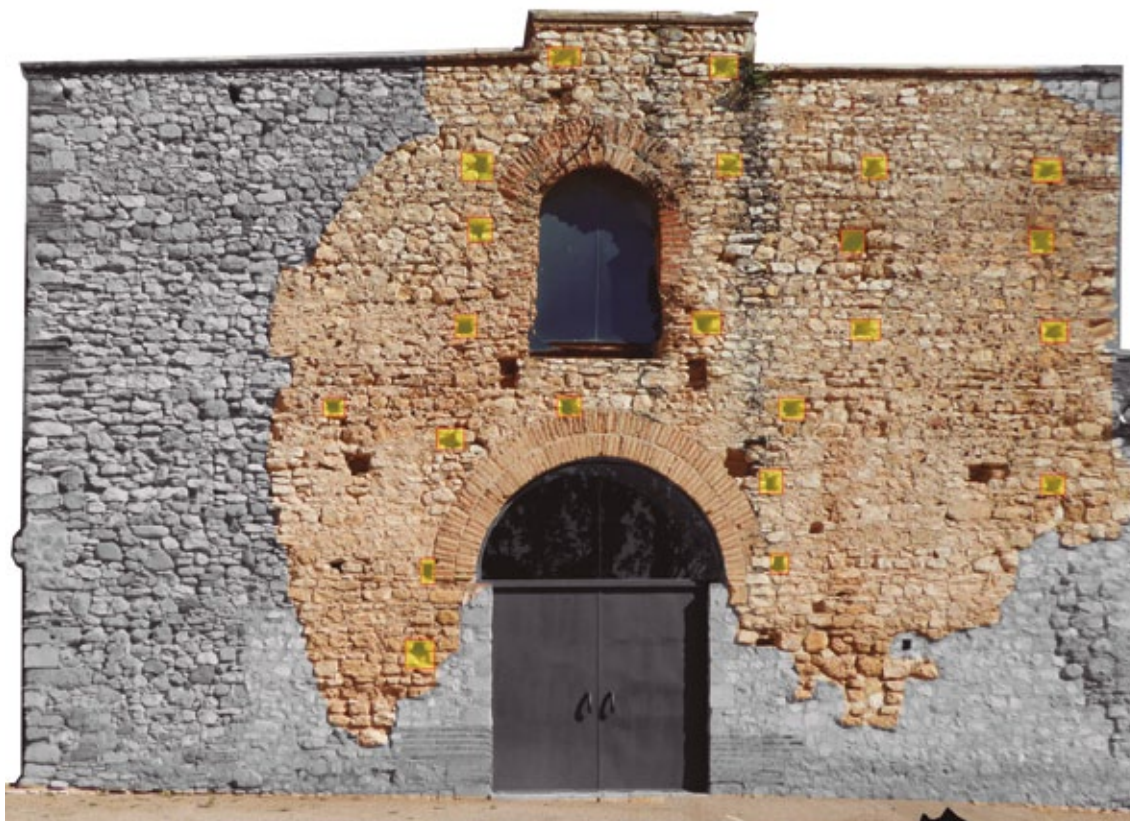
Figura 14 Detall de la sala 8 on s'han remarcat els elements de maó. Centelles. [Fotografia: J. López-J. Puche]
