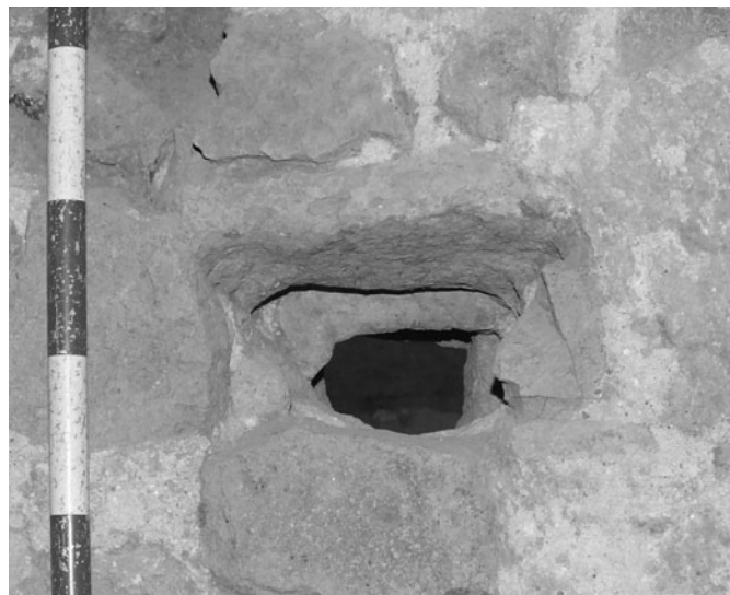
Figura 7 Forat quadrangular de bastida. [Fotografia: Ramon Coll]
