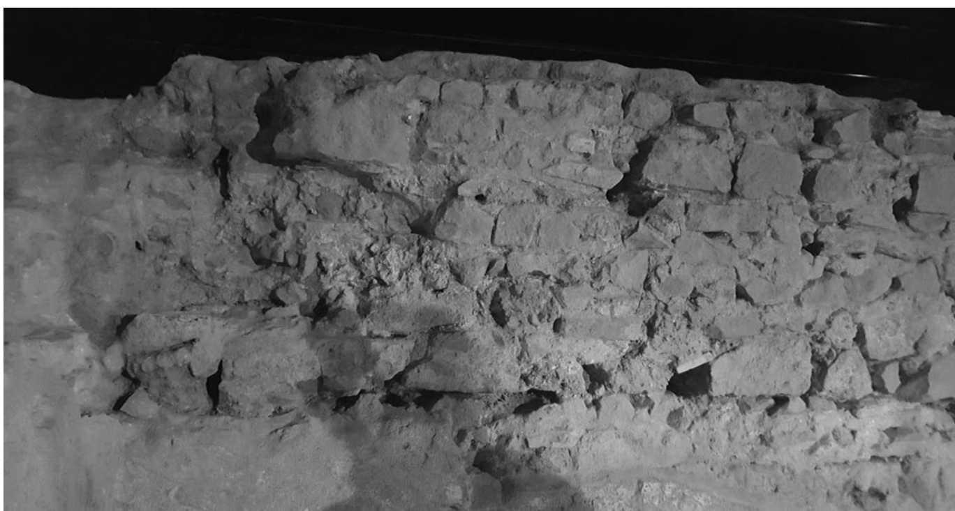
Figura 4 Estructura de mampostería con mortero de cal de la domus de sant Honorat donde podemos ver los diferentes materiales empleados. Destacan los fragmentos de pavimento de opus signinum (excavación de la calle de Sant Honorat). [Fotografía: Julia Beltrán]
