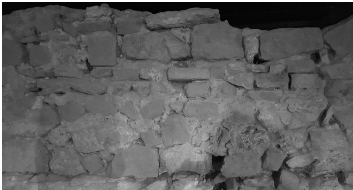
Figura 5 Estructura de mampostería con mortero de cal de la domus de sant Honorat. Se puede ver la disposición poco ordenada, la presencia de ladrillos y la disparidad del tamaño de los mampuestos, así como los elementos de relleno (excavación de la calle de Sant Honorat). [Fotografía: Julia Beltrán]
