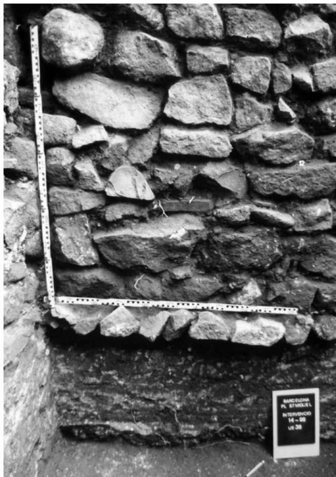
Figura 1 Estructura de mampostería irregular ligada con una argamasa terrosa. Se puede observar la primera hilada realizada en un pseudo opus spicatum (excavaciones de la plaza de Sant Miquel). [Fotografía: Josep Maria Vila]
