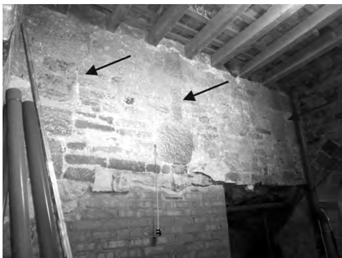
Figura 5 Part del tram amb opus africanum localitzat al Palau Episcopal, amb la indicació de les cadenes verticals. [Fotografia: A. Ravotto]
