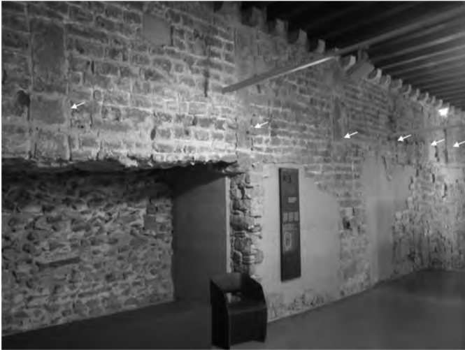
Figura 6 Part del tram amb opus africanum localitzat al Pati d'en Llimona, amb la indicació de les cadenes verticals. [Fotografia: A. Ravotto]
