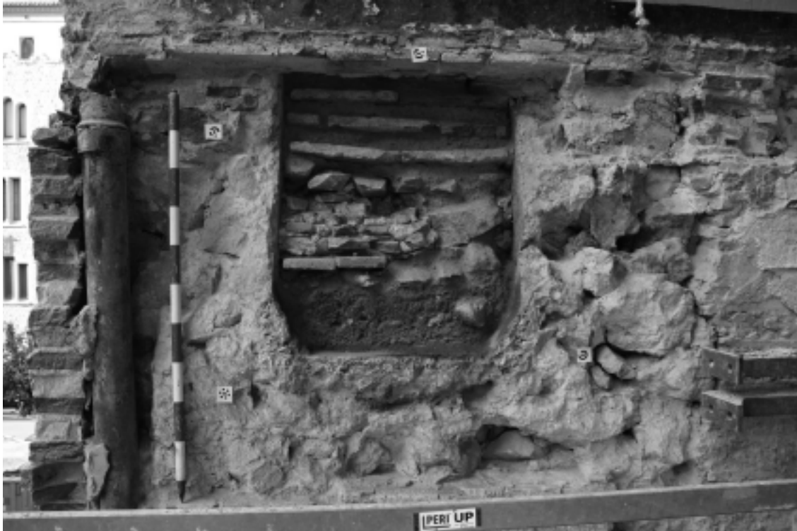
Figura 3 Detall de l' specus de l'aqüeducte de Montcada, a la finca del carrer de Ripoll 25. (Fotografia: Vanesa Triay-Àtics-MUHBA)
