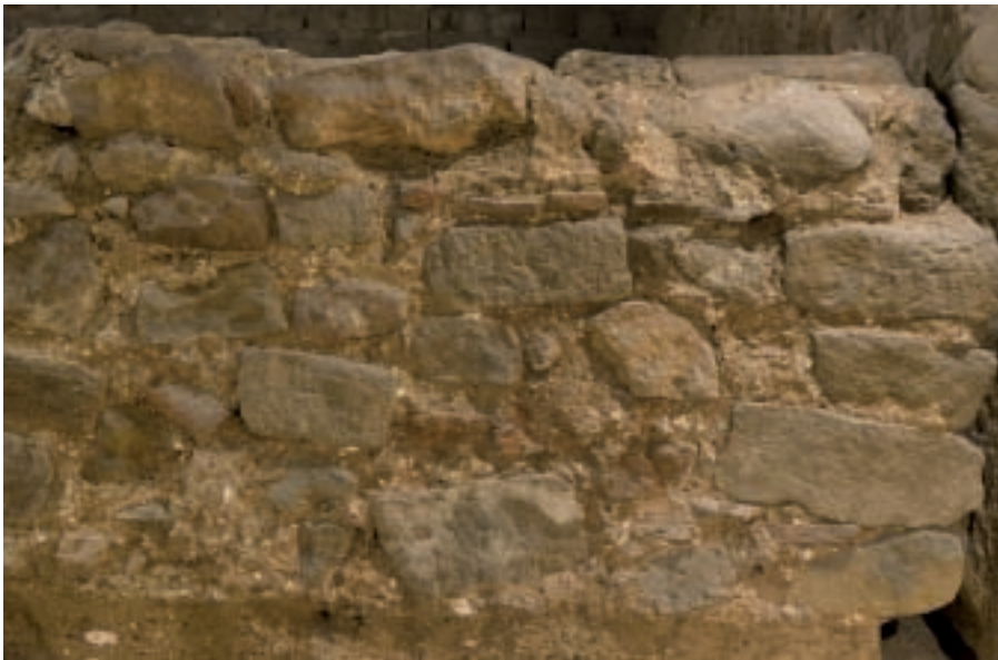
Figura 5 Detalle del paramento de la obra de fábrica del siglo V d.C. Se aprecia el color terroso del mortero. [Foto: Pere Vivas-MUHBA]
