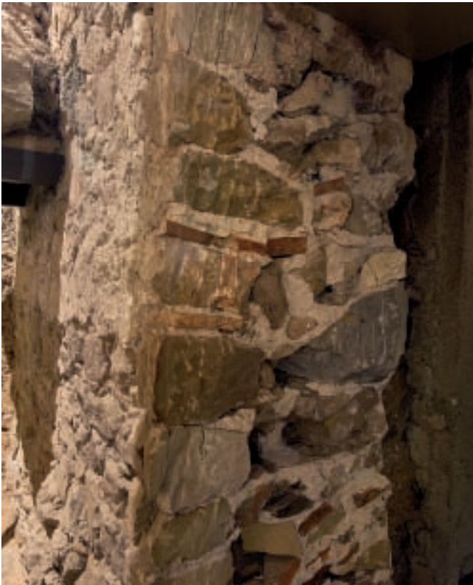
Figura 18 Corte transversal de los cimientos del palacio episcopal del siglo VI d.C. donde puede verse la disposición de las hiladas, la regularización con fragmentos de tegulae y el relleno interior. [Foto: Pere Vivas-MUHBA]
