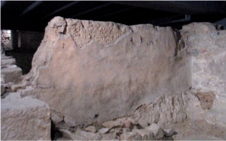
Figura 14 Muro de tapial de las dependencias anexas al aula episcopal. Conserva el revestimiento exterior. [Foto: Núria Miró-MUHBA]
