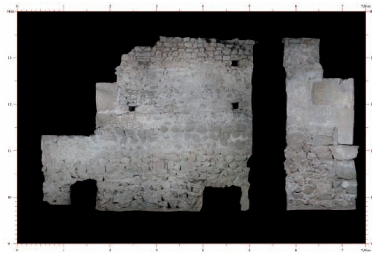
Figura 25 Paramento interior de uno de los cuerpos del palacio episcopal donde se aprecian los mechinales de los andamios. [Alzado ortofotogramétrico: E. Revilla- N. Miró-MUHBA]
