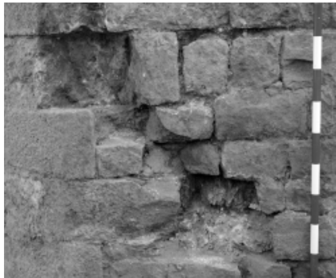
Figura 14 Impactes de bala de canó al parament de la torre oriental del portal de Sant Daniel. (Foto: Marc Bosch)
