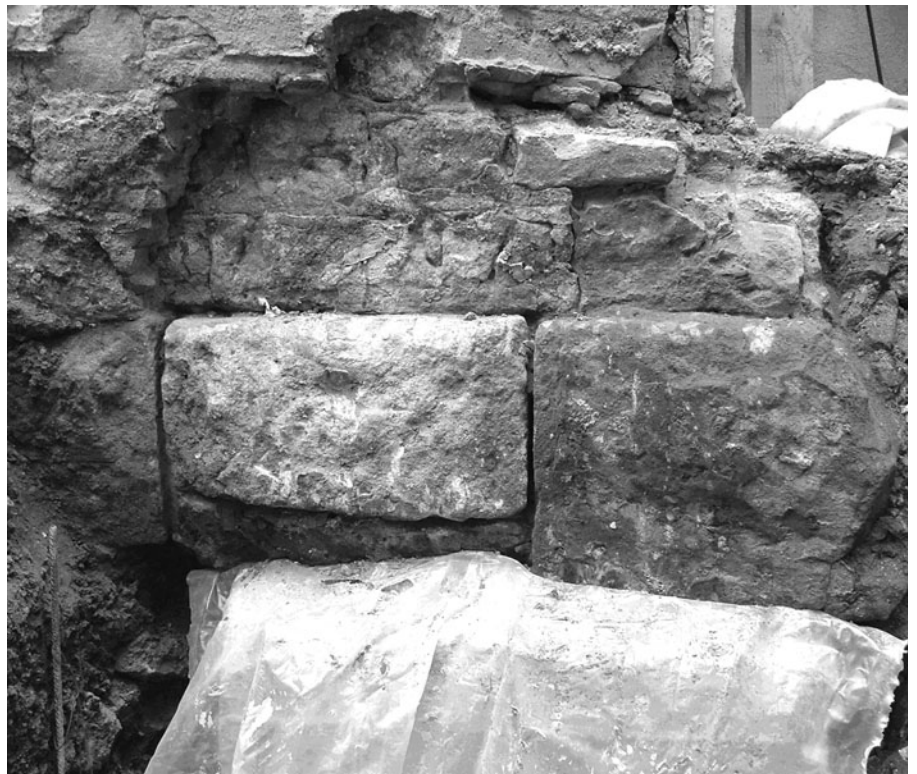
Carrer de les Magdalenes, 25 Aqüeducte. Base d' opus quadratum i arrencament del pilar d' opus vittatum . (Foto: Damià Griñó)
