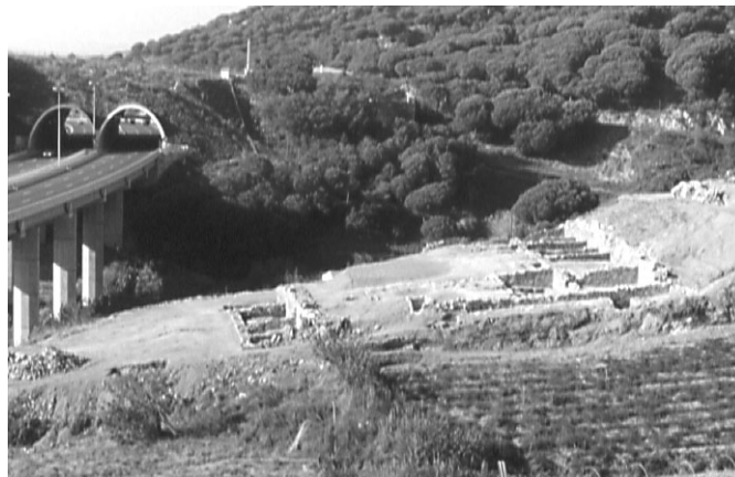
Figura 5 Vista general del conjunt de instal·lacions vinícoles del Morè (Sant Pol de Mar).
