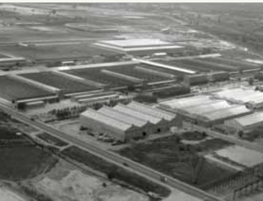
Naus de la SEAT en construcció, 1953-1955. Fons TAF, Helicòpters SA, Arxiu Nacional de Catalunya
