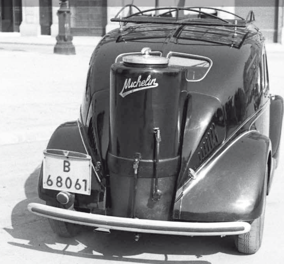
Cotxe equipat amb gasogen de la casa Roig i Pérez. Fotografia de Brangulí (fotògrafs), 1940-45. ANC
