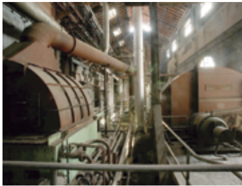
Interior de la Sala de Calderes. Fotografia: Pere Vivas
