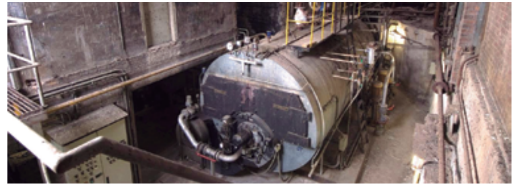
Interior de la Sala de Calderes. Fotografia: Pere Vivas
