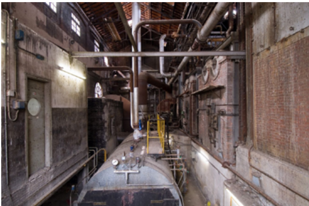
Interior de la Sala de Calderes. Fotografia: Pere Vivas
