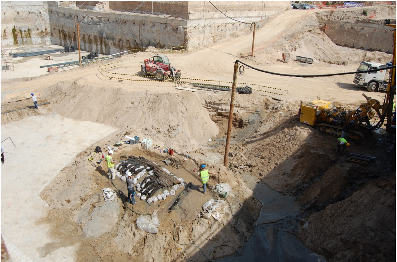
Treballs d’estabilització, remullament i empaquetatge del Barceloneta I (2008). Servei Arqueològic de Barcelona
