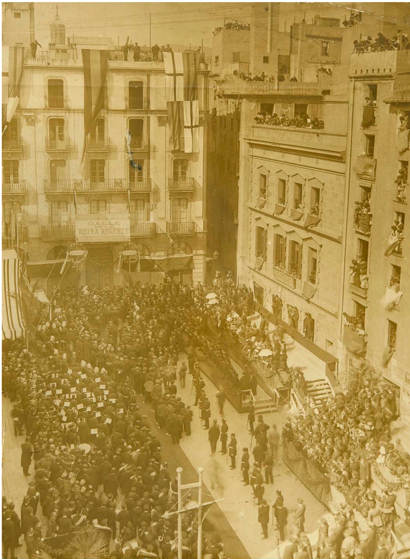
Inauguració de les obres de la reforma de la Via A al carrer Ample. 10 de març de 1908. Adolf Mas
